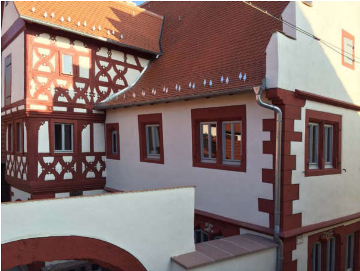
...nach der Sanierung
