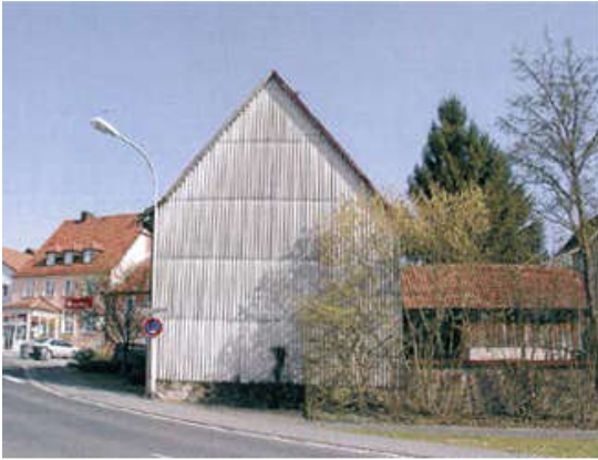
Straßenansicht mit Eternitverkleidung vor...
