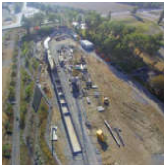
Das Belvedere von oben im Bau...
